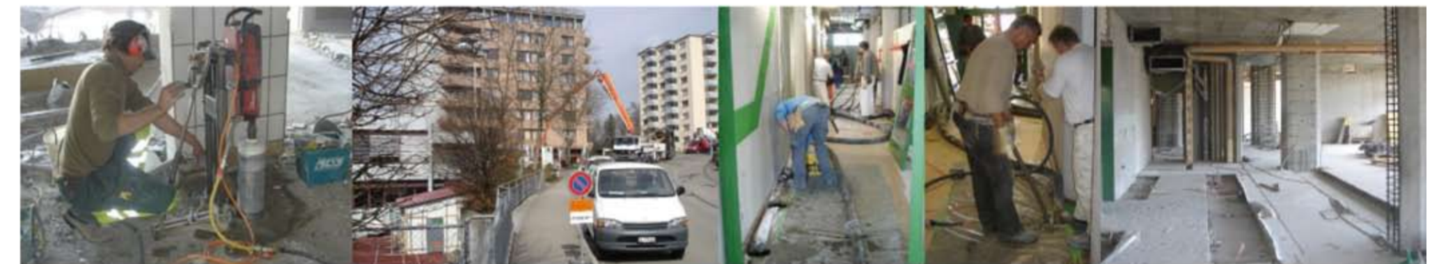
Erdbebensicherheit: Bohren, bohren..., armieren, armieren..., schalen, betonieren, ausschalen...
