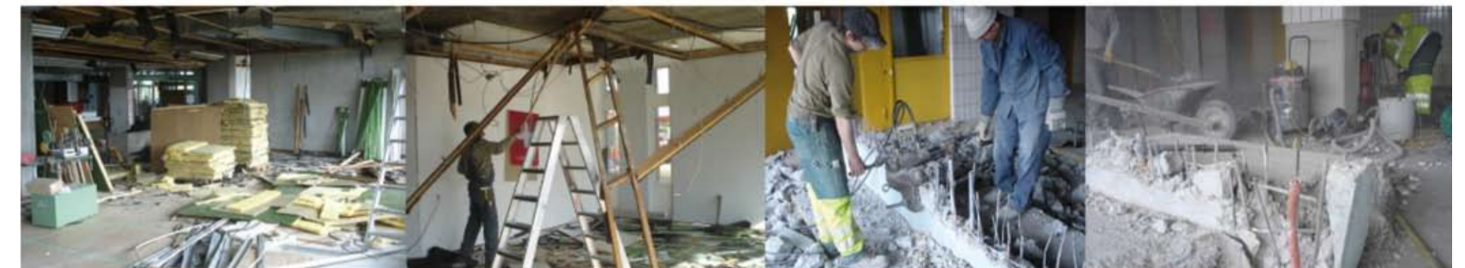
Abbrucharbeiten: Speisesaal, Cafeteria, Bar, Küche... Decken, alte Lüftung, teilweise Heizung, Mauern...
