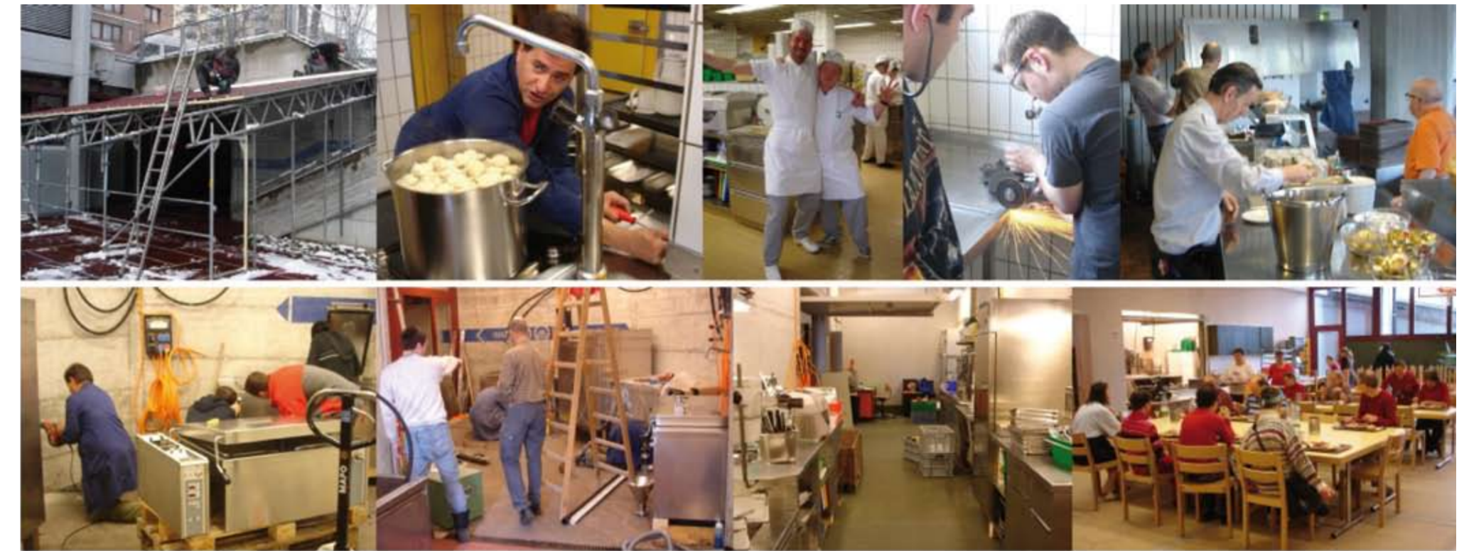
Erstellen Küchenprovisorium: Küche zügeln, noch kochen, alte Geräte installieren, neu in Turnhalle essen
