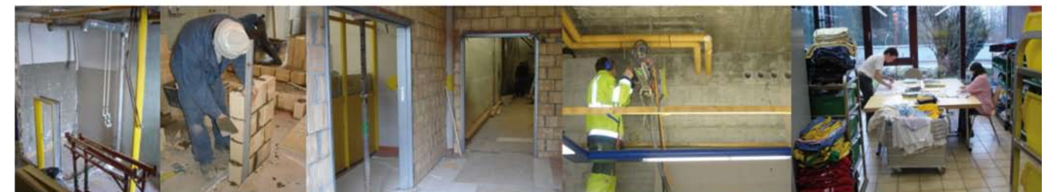
Garderoben Wäscherei im UG erweitern, Sanitär- und Elektroleitungen..., saubere Räume sind gesucht
