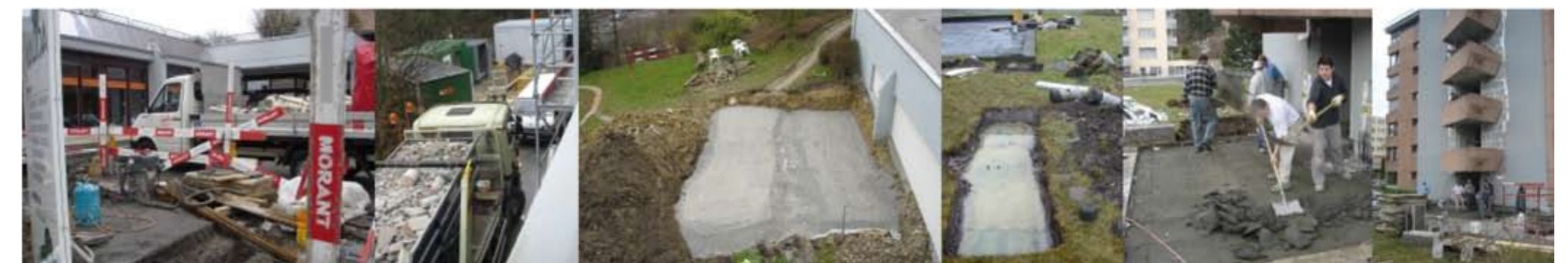
Im Aussenbereich: Dachabdichtungen, Materialabfuhr, Kranplatz bereit, Abbruch Balkone vorbereiten...
